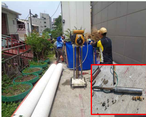
TYPE3(STA.0+85) 용벽 상부 지반상태 확인
