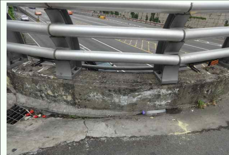
사진7 -S1 방호벽 연석 틀뜸
