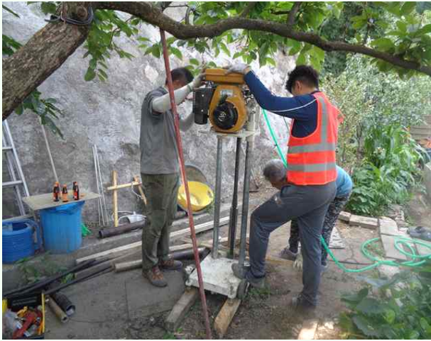
TYPE2(STA.0+32) 용벽 상부 지반상태 확인
